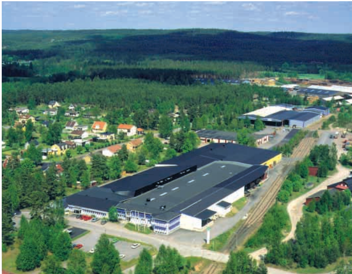
Administratie en productie gebouw te Jarnforsen, Smaland
